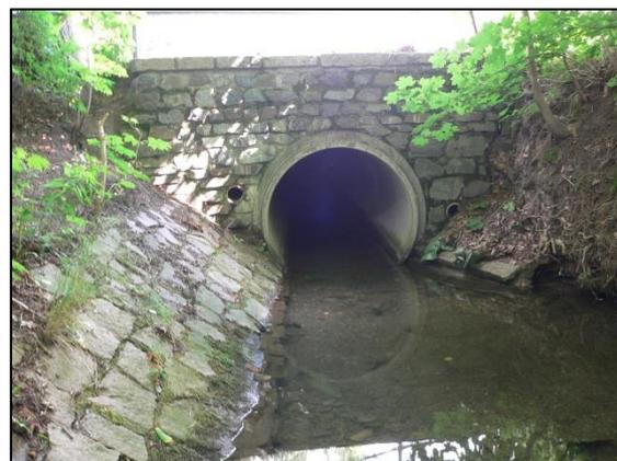
Abb. 12: Verrohrung Gablenzbach DN 1500 unter dem Balzacweg
