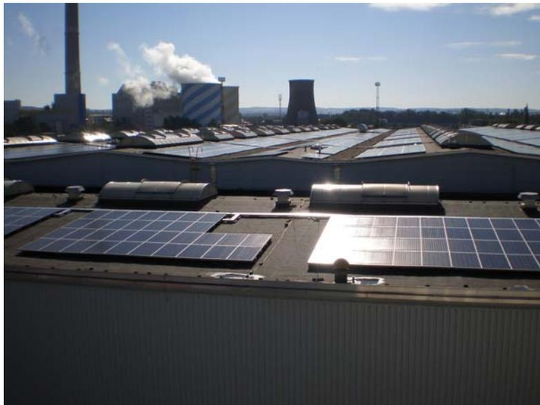
**Abbildung 20: 1,1 MW Fotovoltaikanlage auf dem Dach der ASR Fahrzeughalle**
